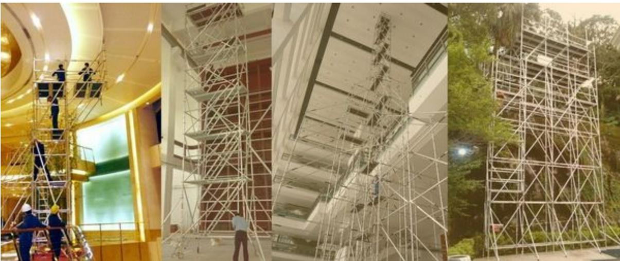
**最重要的是 GN50 铝合金脚手架能搭配铝合金支柱支撑使用搭建成外墙装饰装修作业脚手架**
