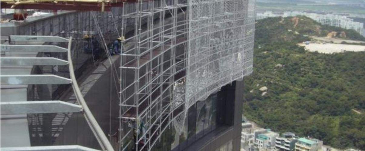
超跨度搭建成桥梁架，重量轻便承载重量大，还可移动。
